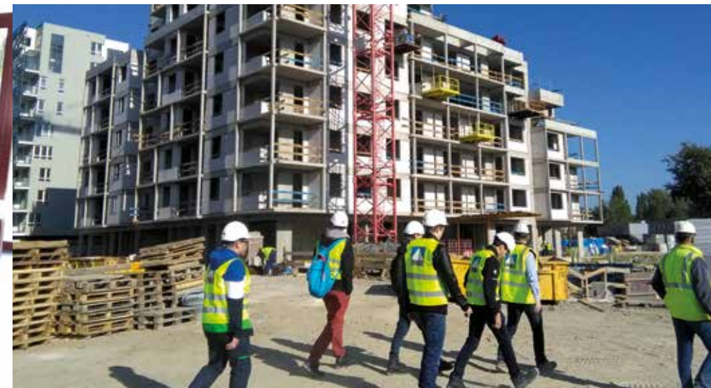
Uczniowie klasy IIa Technikum Budownictwa i Architektury nr 1 w Warszawie podczas zwiedzania placu budowy Central Park Ursynów The students of Year IIa of the Technical College of Construction and Architecture No. 1 in Warsaw during construction site visit of the Central Park Ursynów project
